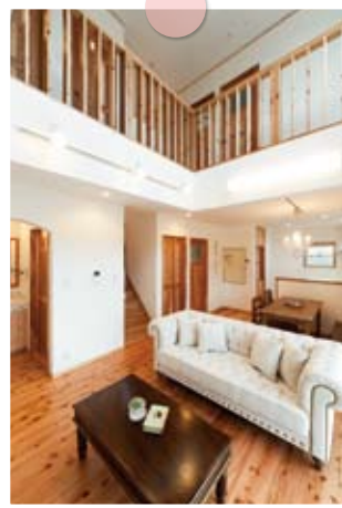
開放感のある吹き抜けのリビング。2階の手すりは構造材で使う間柱を使用
